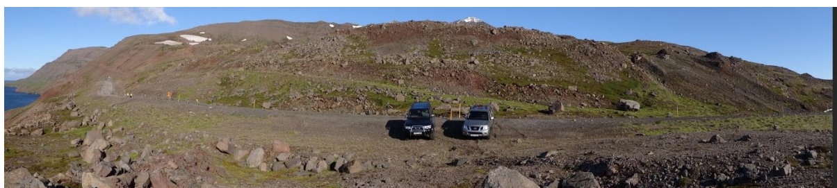
Mynd 5.4 Almenningsnöf er vinstra megin á myndinni. Veglína 76-401 er hönnuð þarna um Tjarnardalaberg-hlaupið nokkuð ofan við gamla veginn, sem sést móta fyrir á myndinni. Mikil skering yrði á öllu þessu svæði og allt skeringarefni flutt burt af vegsvæðinu.
