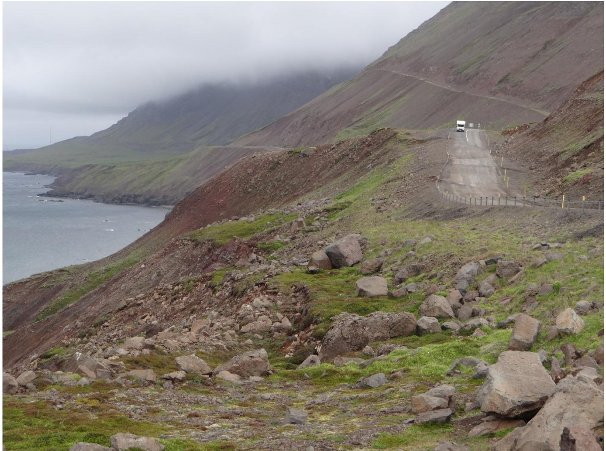
Mynd 2.3 Tekin til norðurs yfir sigsvæðið sunnan við Almenningsnöf. Bíllinn er við Almenningsnöf. Vegurinn er illa farinn enda hefur hann bæði sigið og skriðið fram.
