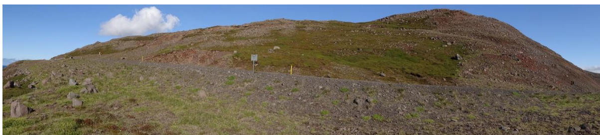
Mynd 5.3 Kónsnefið er hægra megin á myndinni. Veglína 76-401 er í allt að 9% langhalla og með mikilli skeringu um Tjarnardalaberg-hlaupið norðan við Kónsnef.
